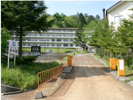
駐車場入口ゲート
