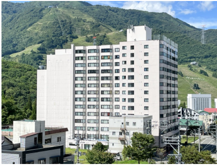
外観（国道17号線沿い）
