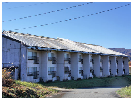
ヴィラ石打1号館 外観
