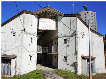
ヴィラ石打3号館 外観
