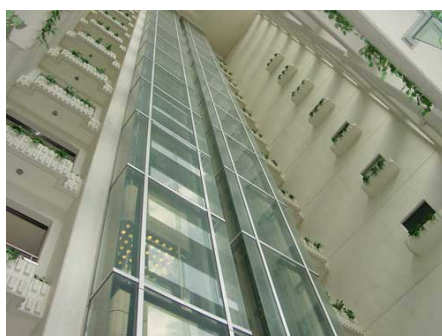
シースルーエレベーター
