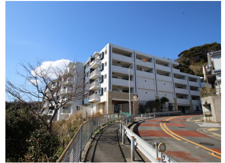
道路側から見た外観
