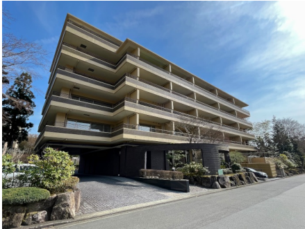
マンション外観
