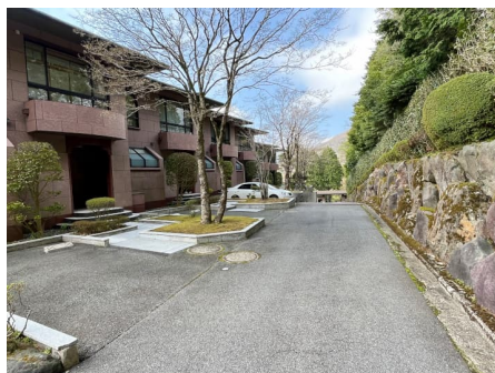
駐車場（各戸1台）
