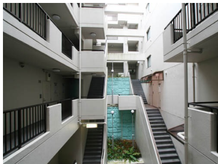
吹き抜け部分
