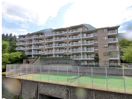
マンション外観 (D棟)
