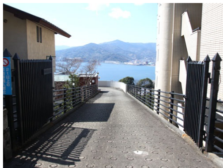
駐車場入口(アプローチブリッジ)
