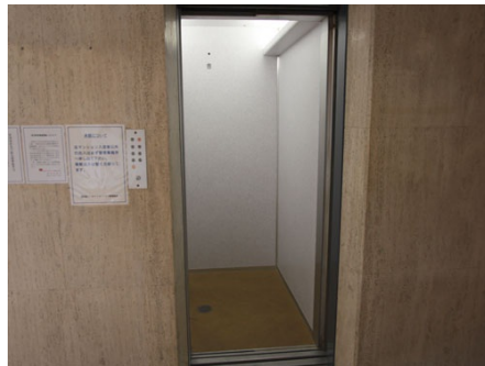
エレベーター
