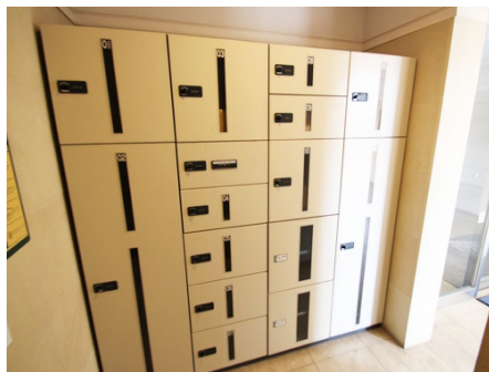
宅配ボックス
