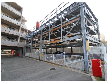
機械式駐車場
