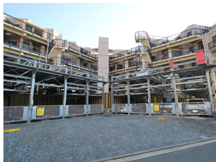
機械式駐車場
