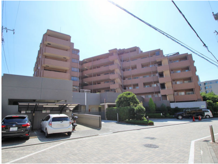
マンション外観
