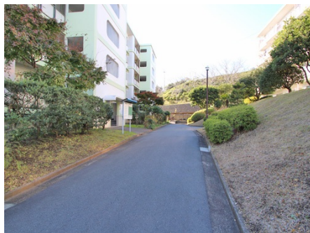
入口への通路
