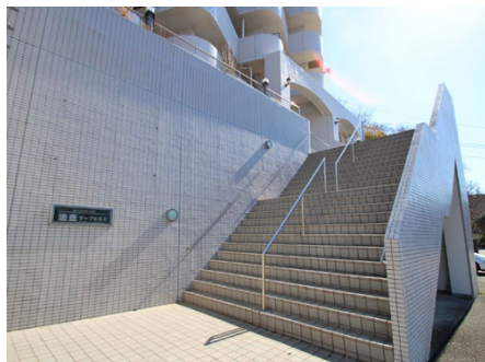
エントランス前の階段
