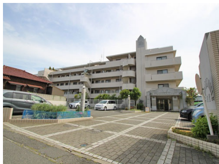
マンション全景
