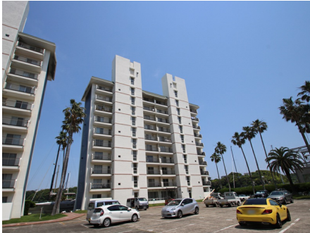
駐車場から見た外観
