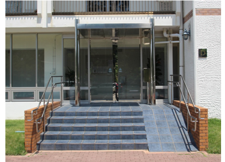
マンション入口 (オートロック)
