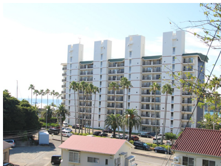
A棟の外観
