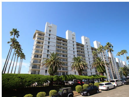
A棟の外観
