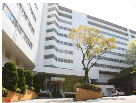
正面玄関付近
