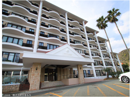
エントランス部
