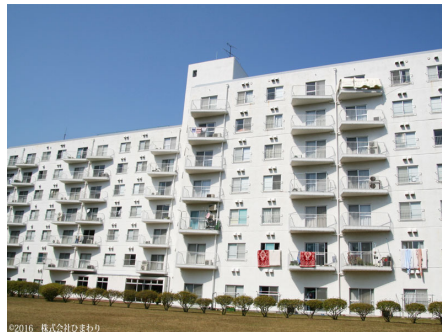
外観エントランス周辺
