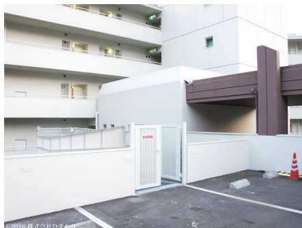
2号棟は台車利用可能
