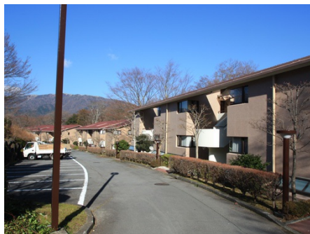
マンション前道路
