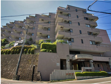
マンション外観
