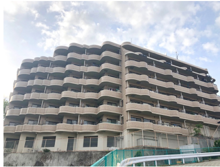
東側からの外観
