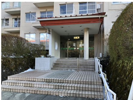
C棟エントランス
