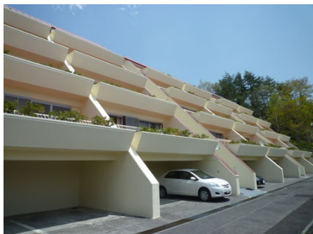
外観（写真はA棟です）
