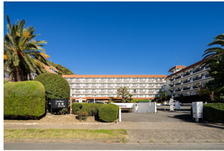
正面から見た外観
