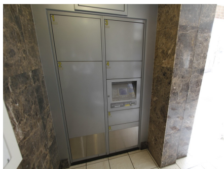
宅配ボックス
