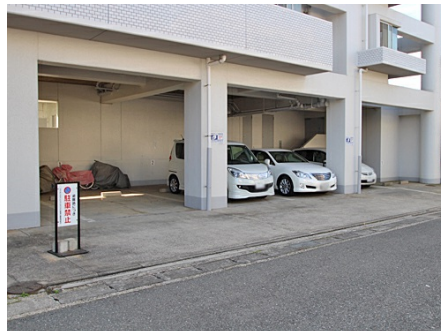
建屋内の駐車場
