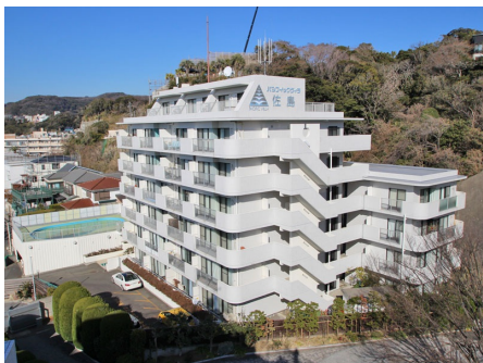
マンション全景
