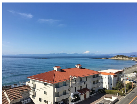
屋上からの景色
