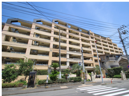
マンション外観
