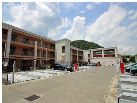
機械式駐車場
