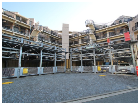
機械式駐車場
