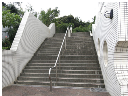
建物正面の階段
