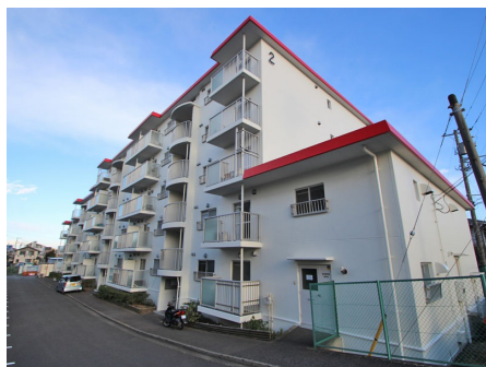
マンション外観(2号棟)
