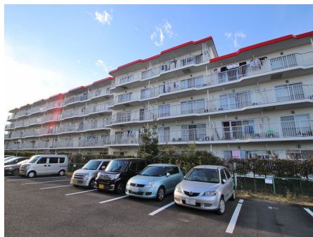
マンション外観(1号棟)
