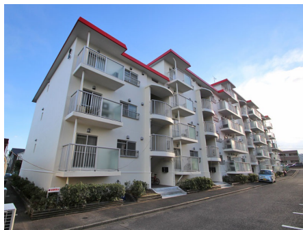
マンション外観(2号棟)
