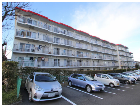
マンション外観(1号棟)
