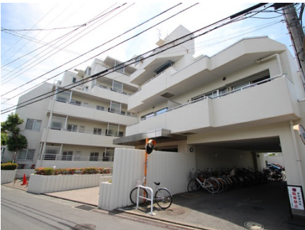
北側からの外観
