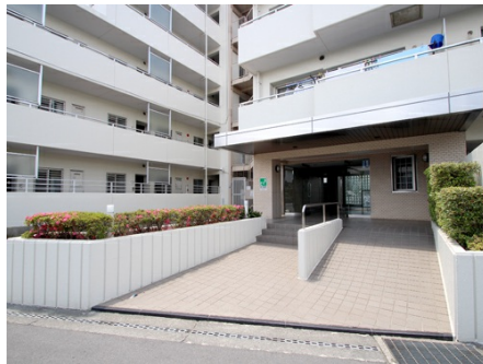
入口のスロープ
