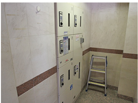
宅配ボックス
