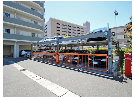
機械式駐車場
