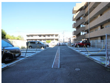
屋外機械式駐車場
