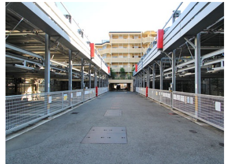
屋外機械式駐車場
