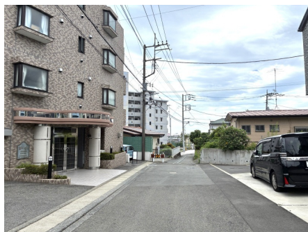
外観と前面道路
