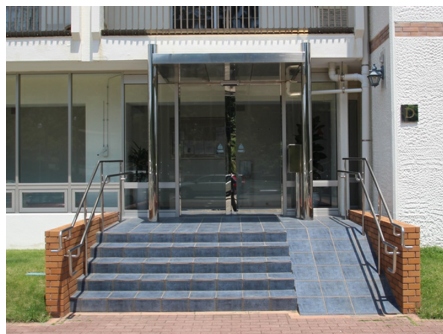
マンション入口（オートロック）
