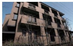
セトル軽井沢 総戸数：26戸 / 竣工：1990年8月
