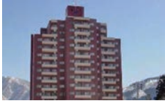
シルバーグレース湯沢1番館 総戸数：108戸 / 竣工：1989年10月
