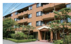
ベルエアコート山中湖 総戸数：25戸 / 竣工：1989年7月
