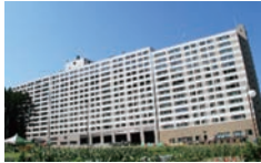
エンゼルリゾート越後中里 総戸数：723戸 / 竣工：1992年9月
