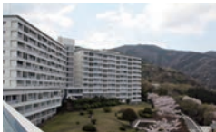
伊東マンション本館 総戸数：149戸 / 竣工：1965年4月
