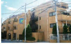
アーバンヒルズ熱海 総戸数：58戸 / 竣工：1990年11月
