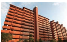
ロイヤルマンション伊豆長岡 総戸数：118戸 / 竣工：1990年4月
