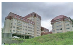
トーコー湯沢 総戸数：193戸 / 竣工：1979年11月
