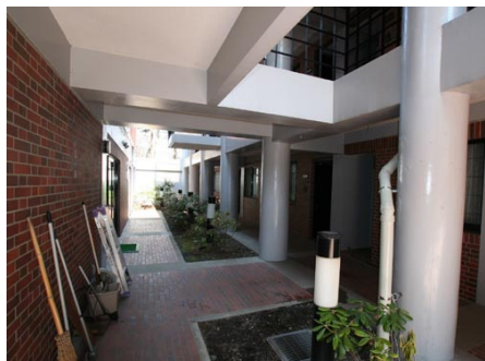
共用廊下の様子
