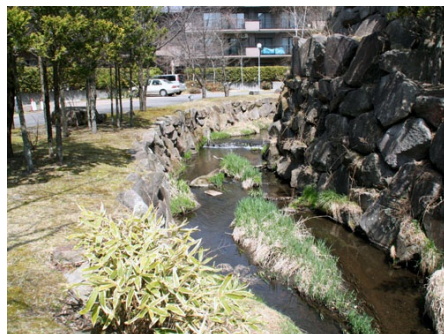
敷地内の塩沢川 (天然)
