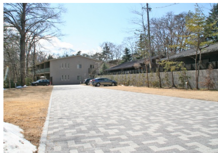
駐車場の様子
